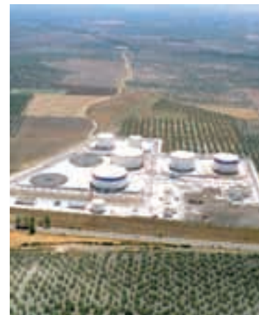
Vista aérea de la instalación / CLH
